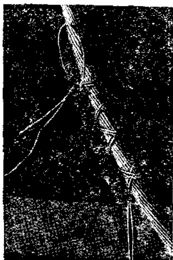
Фиг. 179. Крепление провода вязкой
