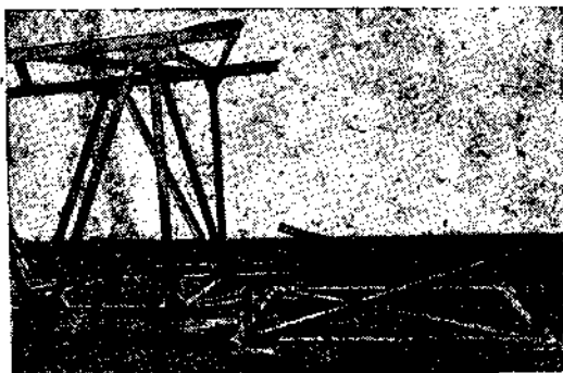
Фиг. 76. Шарнирное соединение опоры немецкого типа с разъемным основанием при подъемке опор
