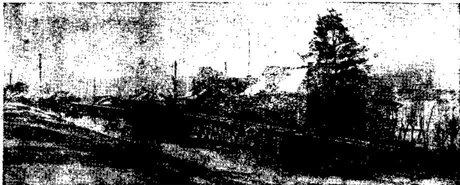
Фиг. 33-а. Развозка частей металлических опор с базы
