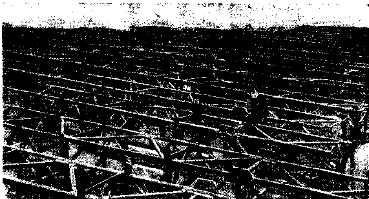
Фиг. 32-б. Приемка металлических конструкций опор на базе
