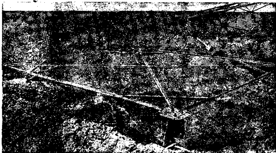
Фиг. 49. Установка металлических подножников в котловане
