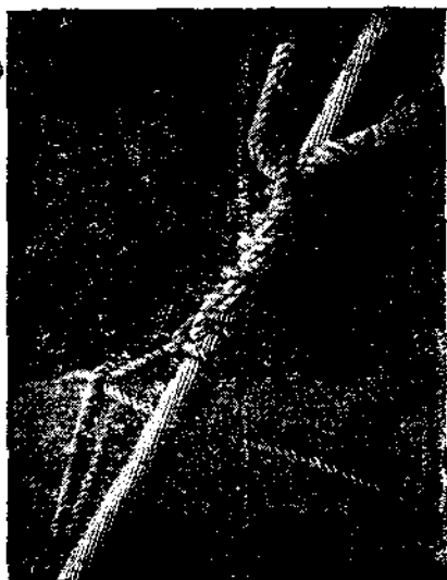
Фиг. 180. Захлестывание провода веревкой при вязке во время выборки „слабины“
