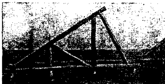
Фиг. 205. Плоский ледорез для П-образной опоры
