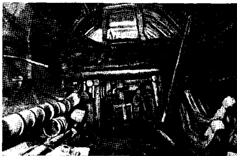
Из опущенной шахты проходчики врубаются в землю двумя параллельными штольнями по направлению будущего тоннеля
