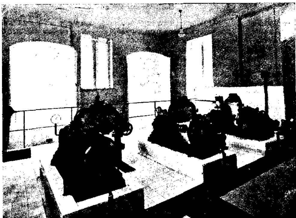
Фиг. 112. Автоматическая станция для города в 50 000 чел.
