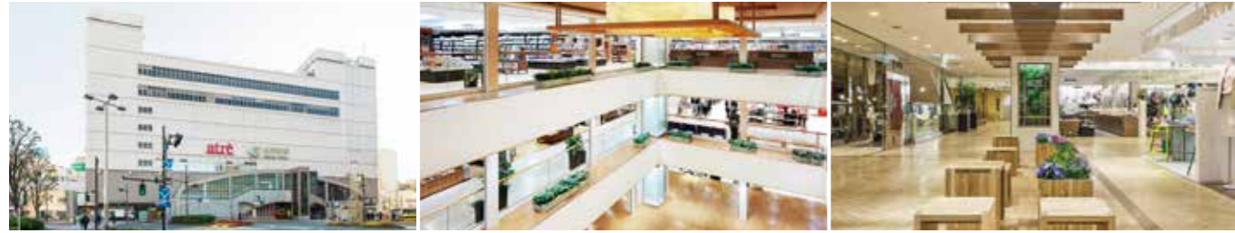
[アトレ大井町] 開業：1993年3月11日 SC階数：地上7階 SC延床面積：24,353㎡ 店舗面積：9,516㎡ [アトレ大井町2] 開業：2011年3月3日 SC階数：地上3階 SC延床面積：1,477㎡ 店舗面積：950㎡
