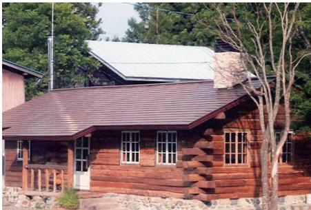
写真 3-5 丸太組構法 外部両面丸太現し（外部）
