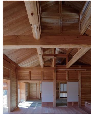
写真 2-5 片面真壁造の落とし込み板壁
