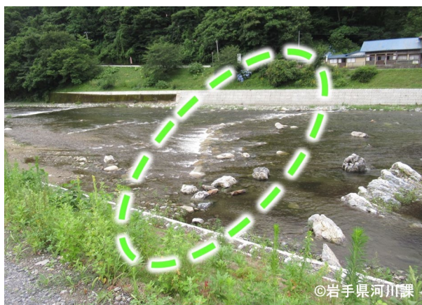
現地発生材を利用した水制工の設置
