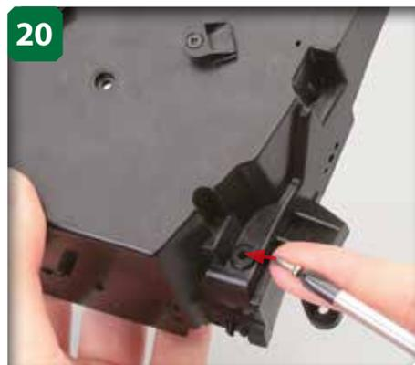
Retournez l'assemblage et introduisez une vis autoforeuse M2,3 x 6 mm dans le trou indiqué.
