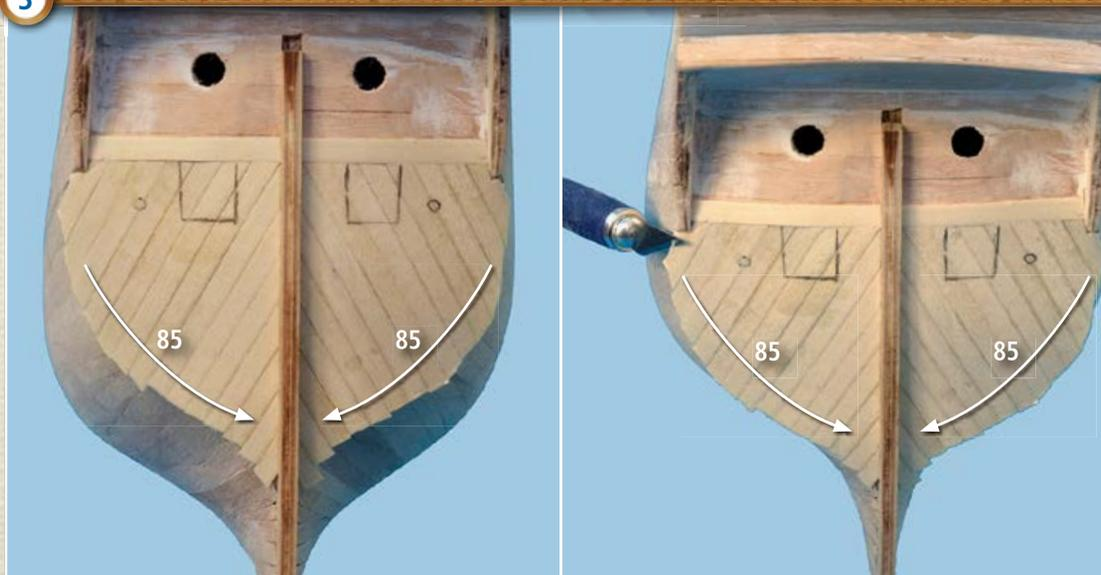
3 Tapissez toute la partie inférieure de la poupe en utilisant les baguettes 85. N'oubliez pas de dessiner à nouveau le profil des deux sabords des batteries et des deux petits sabords ronds qui seront effectués par la suite. A l'aide d'un cutter bien aiguisé coupez les extrémités des baguettes.
