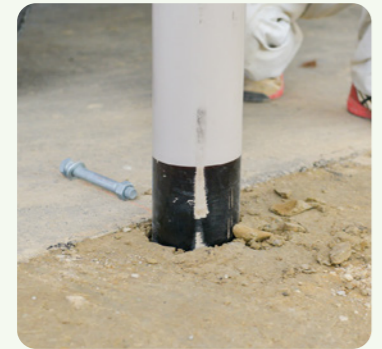
1人が支柱を支え、もう1人が操作を行っていた支柱打ち込み作業を1人でできるように。
