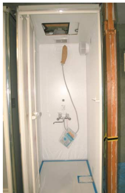
▲2Fにシャワーユニットを8台設置します。
