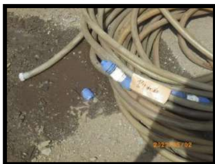
水道ホース ⇒ 破損あり、交換済
