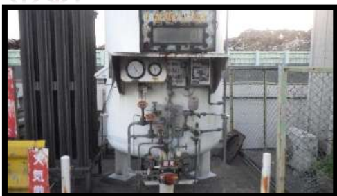
液体酸素タンク ⇒ 異常無し
