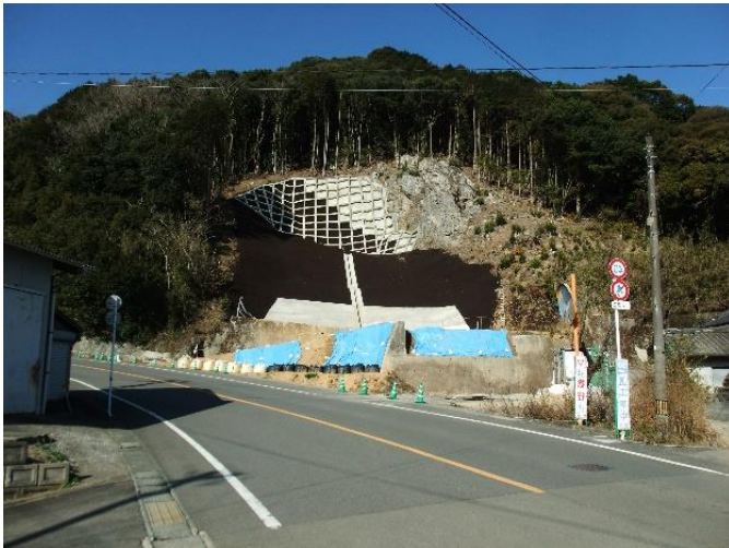
緊急的な砂防施設(急傾斜)整備完了(塩尾・芦北町)
