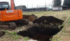
・実習水田における雨水浸透実験のための試掘 ・今後、地下浸透樹を設置し、地下浸透効果を検証
