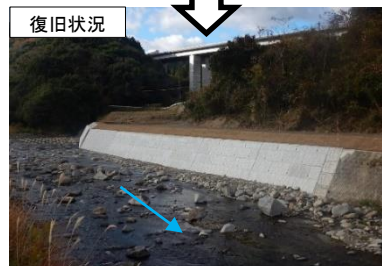
災害復旧工事完了(鳩胸川・人吉市)
