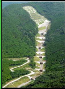
(1)階段状治山ダム
