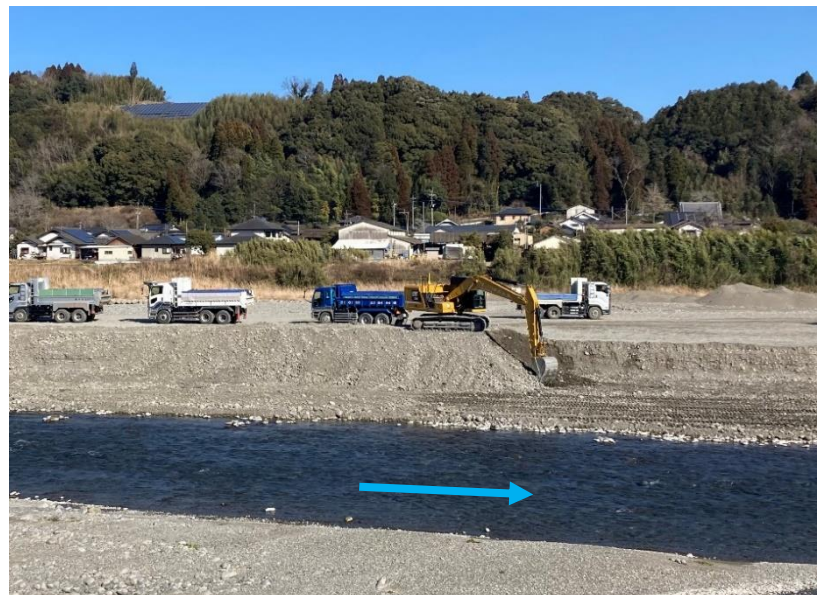
河道掘削状況(川辺川・相良村)
