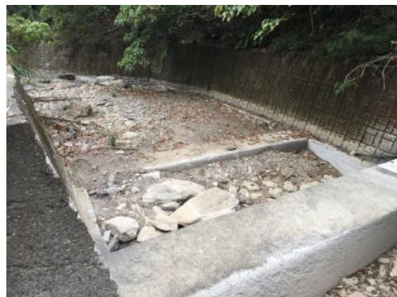
圖 4-13 武潭瀑布排水河堤
