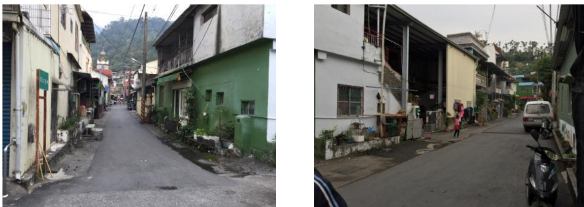
圖 2-27 武潭社區住宅現況
