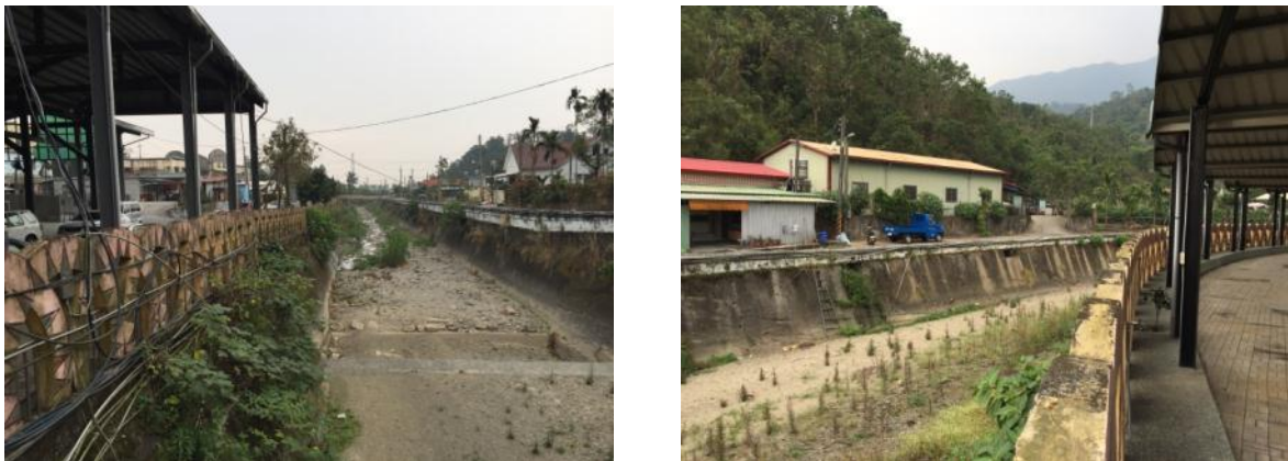
圖 4-9 武潭社區外環道第二河堤
