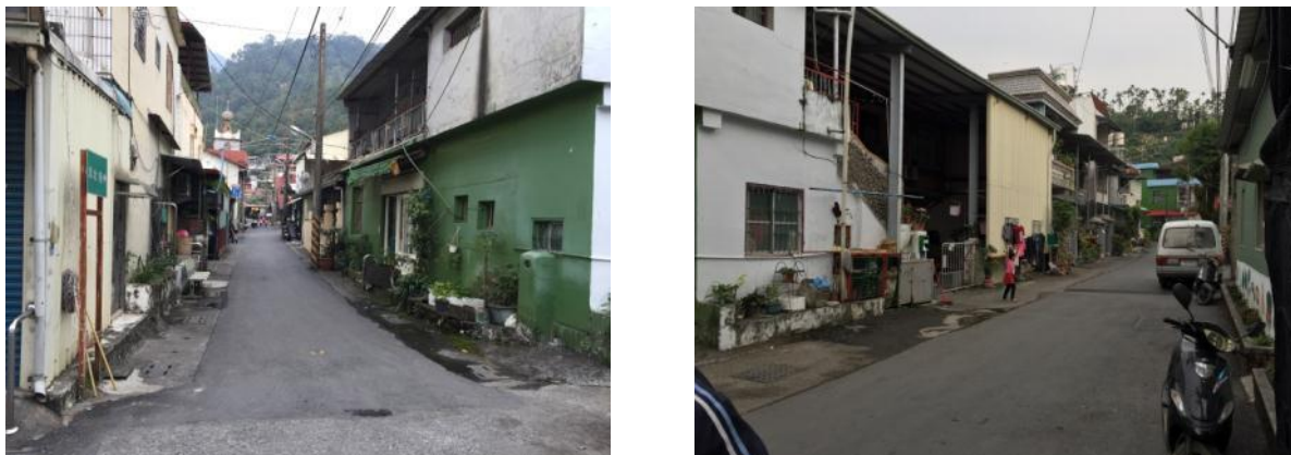
圖 2-27 武潭社區住宅現況
