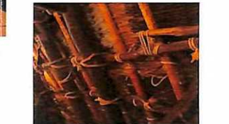
木材の組立てには、釘やカスガイは 一切用いず、荒縄やネジで 緻密に結束してあります。
