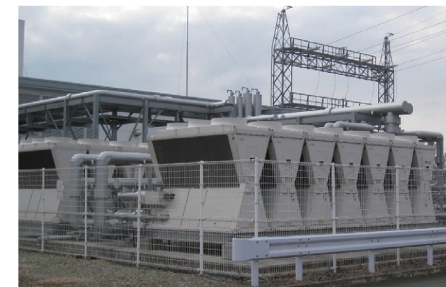
ヒートポンプ式冷熱源設備(持田製薬工場(株)本社工場)
