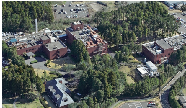
総合研究所 (静岡県御殿場市)
