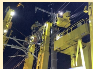
電柱耐震工事
