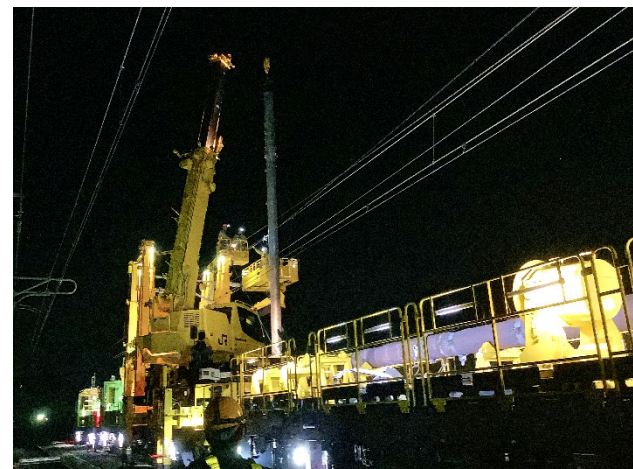
鋼管製の電柱への取り替え
