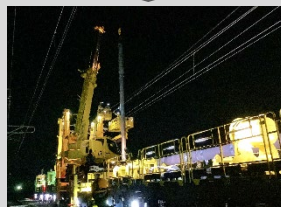
鋼管製の電柱への取り替え
