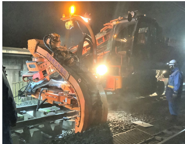
道床掘削機による道床交換工事
