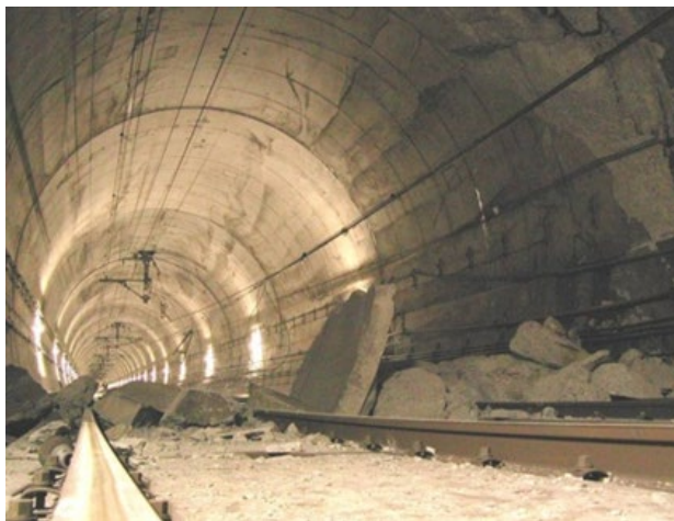
新潟県中越地震でのトンネル剥落
