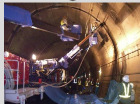
トンネルへのロックボルト施工
