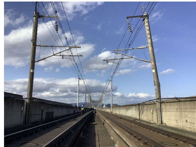
福島県沖地震での電柱傾斜
