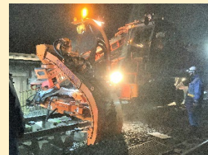
道床交換工事
