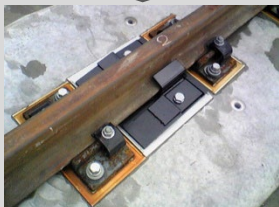
レール転倒防止装置の設置
