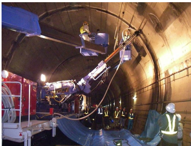
トンネルへのロックボルト施工
