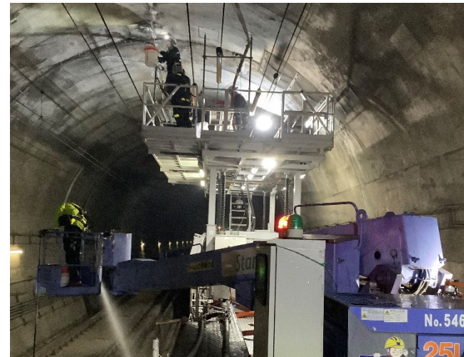
作業用車によるトンネル補強工事
