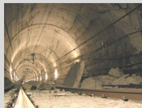
トンネル剥落防止
