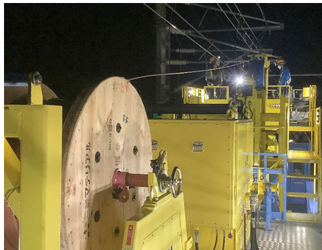
架線延線車による架線改良工事
