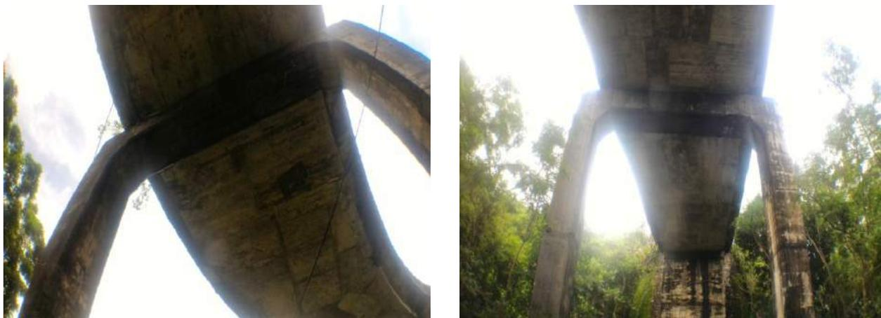
圖 4-13 緩降一、二號橋，均已年久失修水泥剝落鋼筋裸露。
