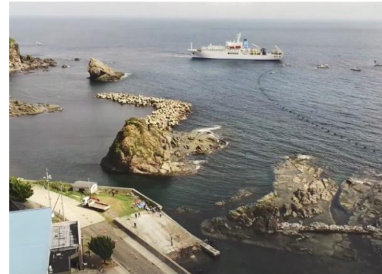
酒田市の離島飛島での 海底ケーブル敷設作業 ▶
