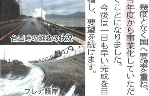
台風時の越波の状況 フレア護岸
