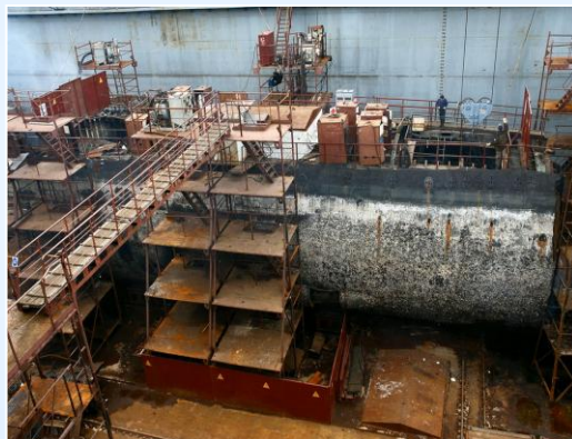
解体作業中のチャーリーⅠ級原潜（北東地域修理センター）
