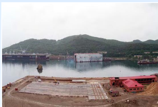
原子炉区画陸上保管施設建設現場(ラズボイニク湾)
