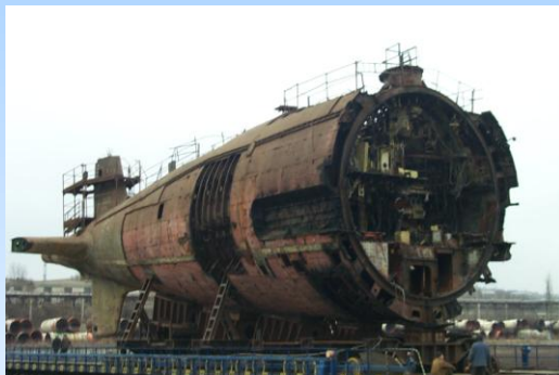
解体作業中のヴィクターⅢ級原潜304号(ズヴェズダ造船所)
