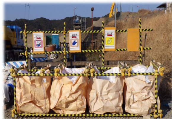
R3年度 四万十川入田樋門新設外(その1)工事現場にて産業廃棄物分別の様子
