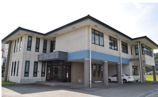
株式会社アース建設本社
