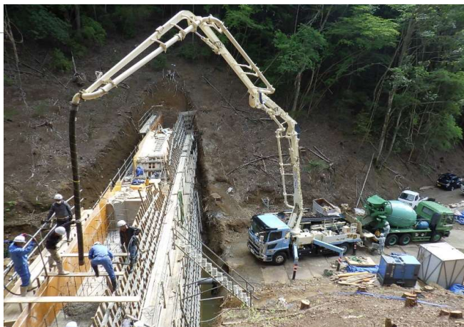
施工の様子(左)コンクリート打設 (右)重機によるICT施工
