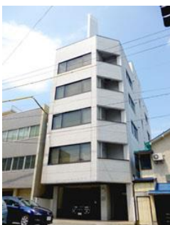
ITC米沢ビル
