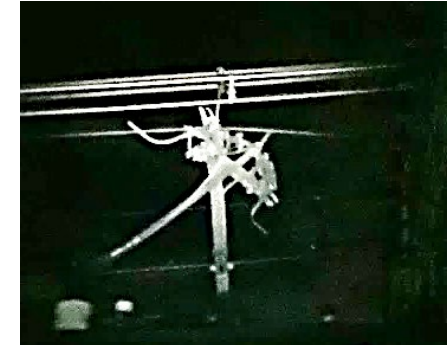
⑤パンタグラフ損傷
