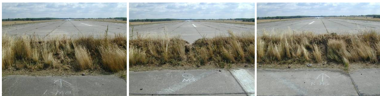
Westseite des ca. 70 cm hohen Erdwalls mit Anprallspuren des linken Haupt-, des Bug- sowie der rechten Hauptfahrwerks Fotos: BFU
