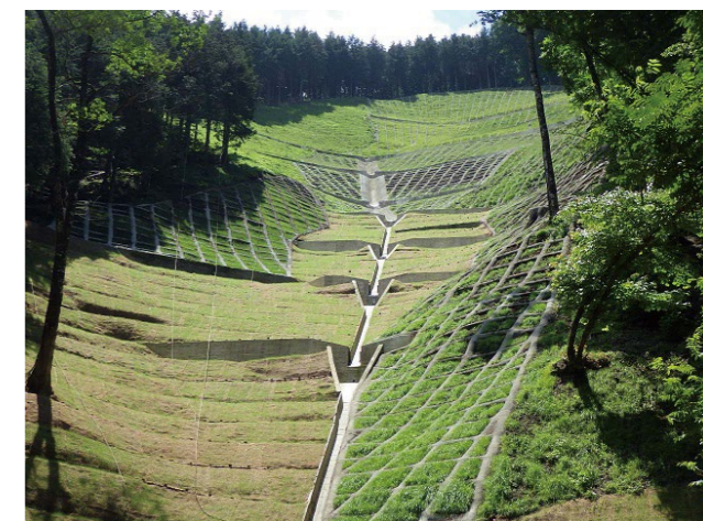
施工事例：崩壊のり面の緑化
