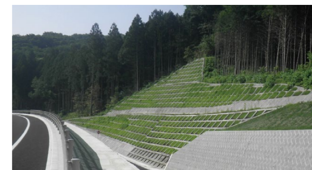
施工事例：上信自動車道
