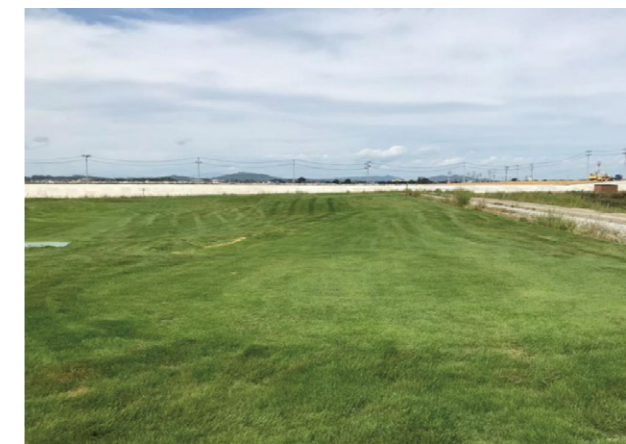
登米市パークゴルフ場建設工事（宮城県登米市）
