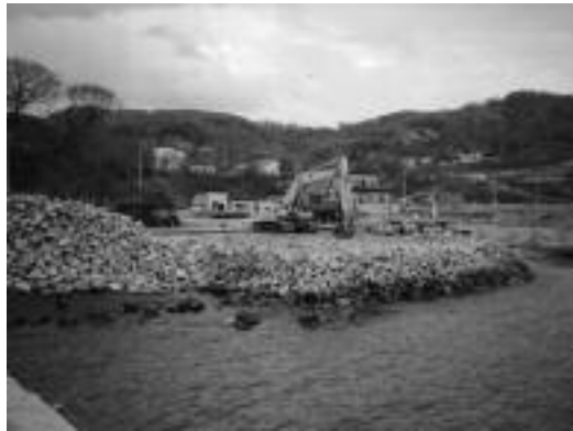
塩谷漁港船揚場の新設工事
