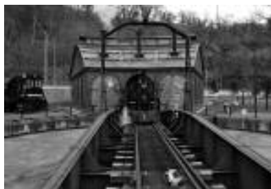
保存修理が完了した機関車庫三号
