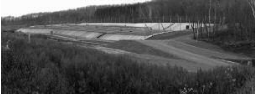
廃棄物最終処分場の第2期埋立地
