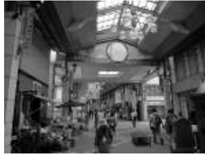
整備が完了した都通り商店街
