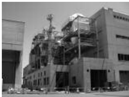
更新された汚泥焼却設備
