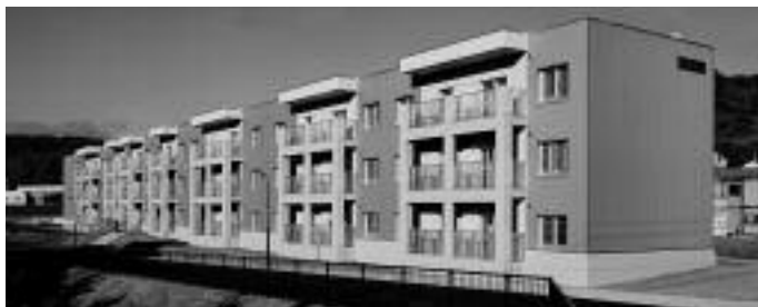
完成したオタモイ住宅3号棟
