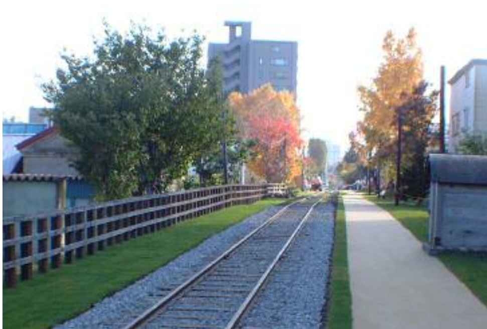
オープンスペースとして整備された旧国鉄手宮線
