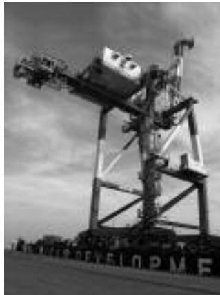
港町ふ頭に設置されたガントリークレーン
