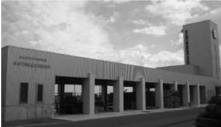
祝津に完成した水産廃棄物処理施設
