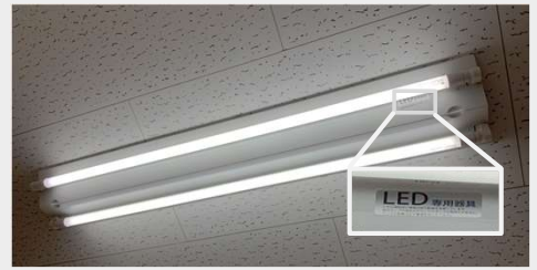
工場棟・事務棟ともに蛍光灯からLEDに交換。
