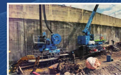
土木・建築工事施工・リース
