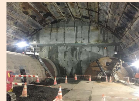
掘削状況(日吉方を望む)
