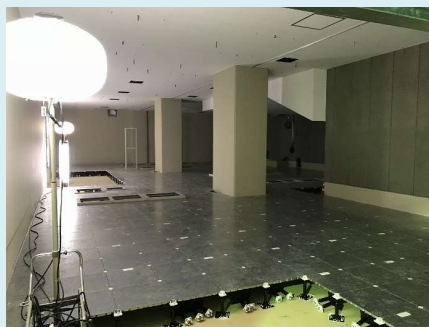
機器室施工状況
