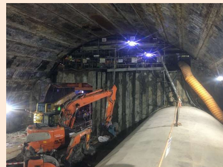
掘削状況(新綱島駅を望む)
