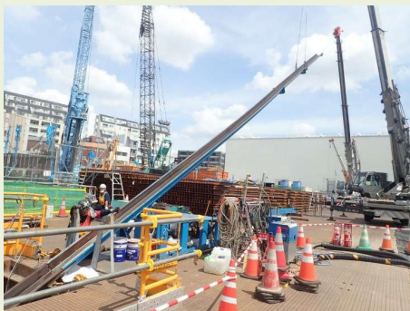
レール投入状況(新綱島駅開口部)
