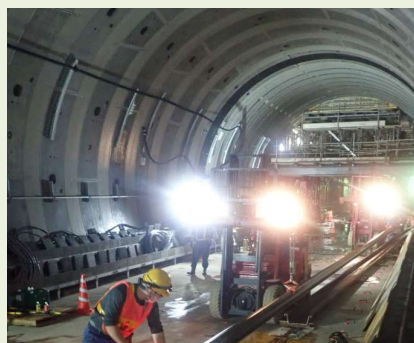
レール運搬状況(新横浜トンネル坑内)
