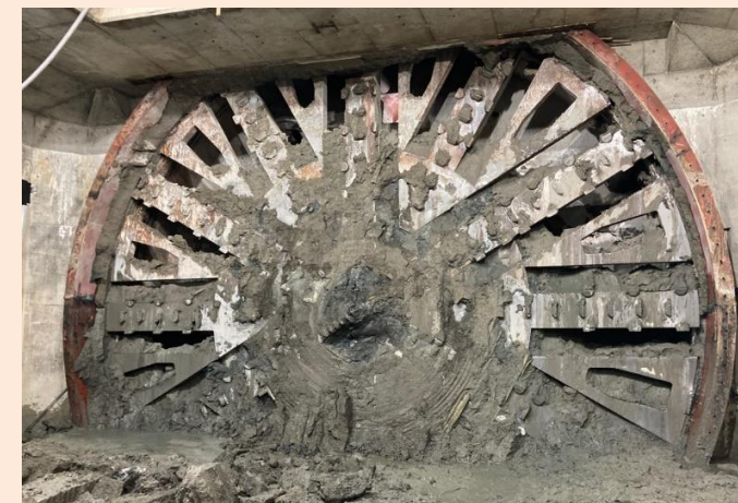
新横浜トンネル 到達状況
