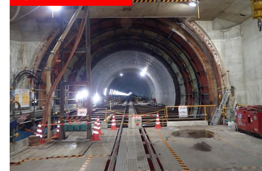
②新横浜トンネル
