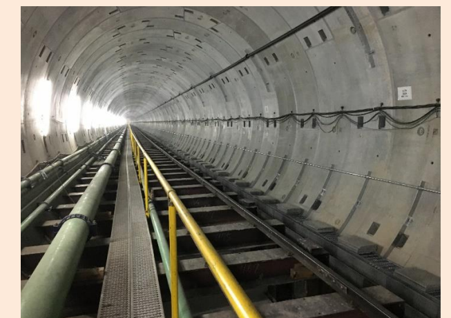
綱島トンネル 坑内状況
