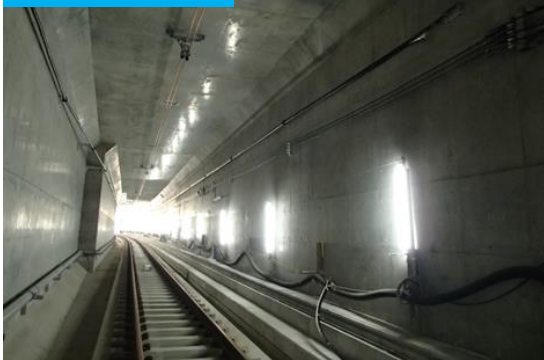
②西谷トンネル
