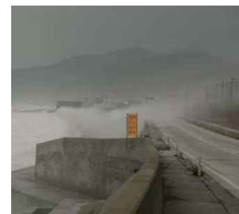
国道7号越波状況 (府屋地区)
