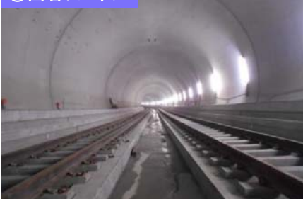
②西谷トンネル
