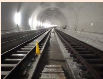
西谷トンネル
