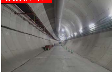
⑤羽沢トンネル
