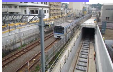
①西谷駅周辺(開削トンネル部)
