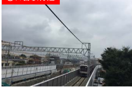
⑧日吉駅付近
