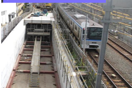
①西谷駅周辺(開削トンネル部)
