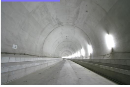
②西谷トンネル
