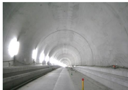
③ 西谷トンネル内（シールド区間）
