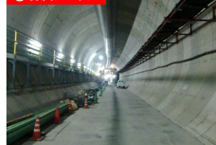
⑤羽沢トンネル
