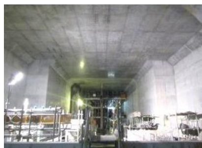
② 西谷トンネル内（箱型区間）
