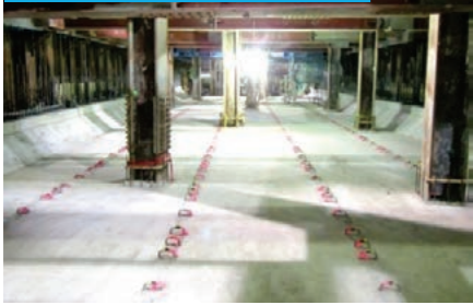
①西谷駅周辺(開削トンネル部)
