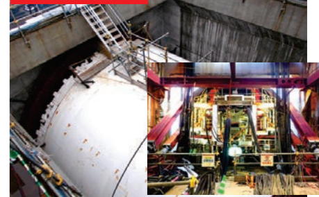
⑤羽沢トンネル
