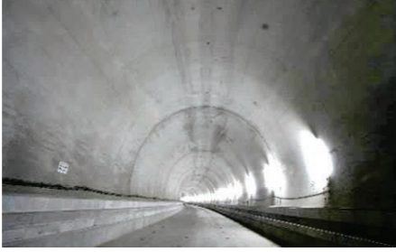
②西谷トンネル
