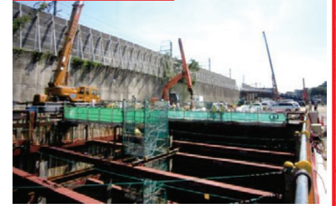
⑤羽沢トンネル
