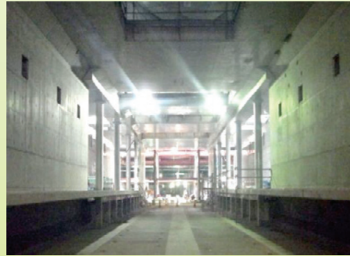
工事の状況(ホーム階)
