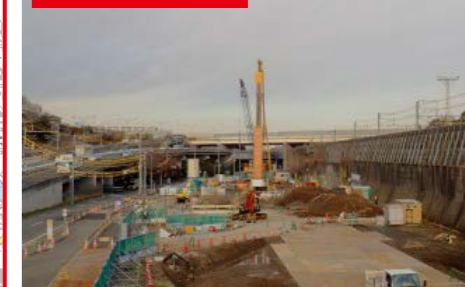
⑤羽沢トンネル
