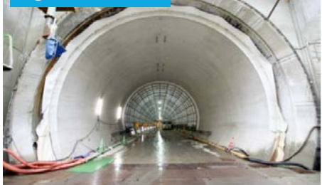
③西谷トンネル
