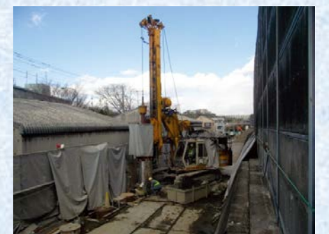
作業構台の基礎を施工中
