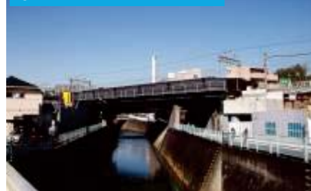
①西谷駅付近(引上げ線)
