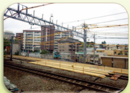
日吉駅付近：軌道内木製覆工設置
