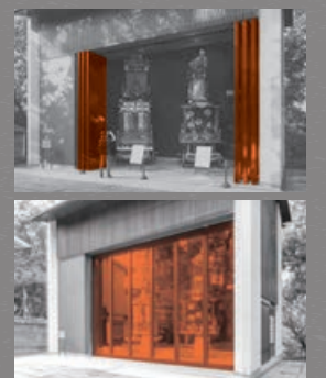
⑦ 赤坂氷川山車展示場 [東京都港区・2021] 1 開放時 2 閉鎖時 STスライドシステム | ステンレス 塗装仕上
