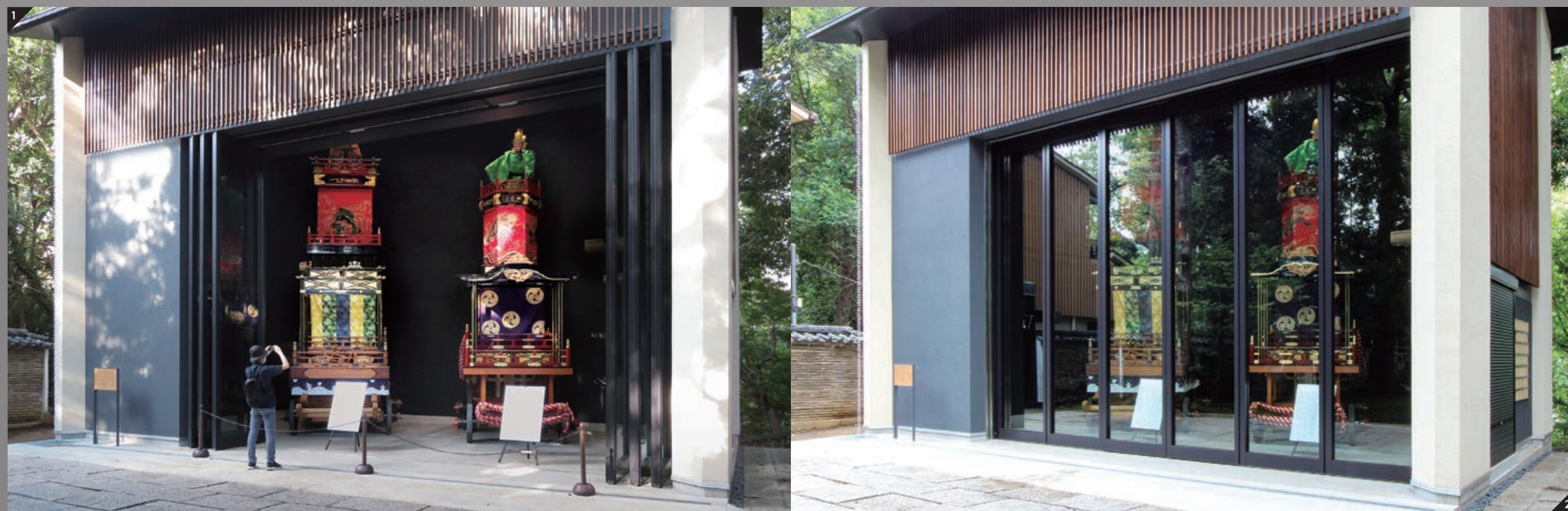
⑦ 赤坂氷川山車展示場 [東京都港区・2021] 1 開放時 2 閉鎖時 STスライドシステム | ステンレス 塗装仕上
