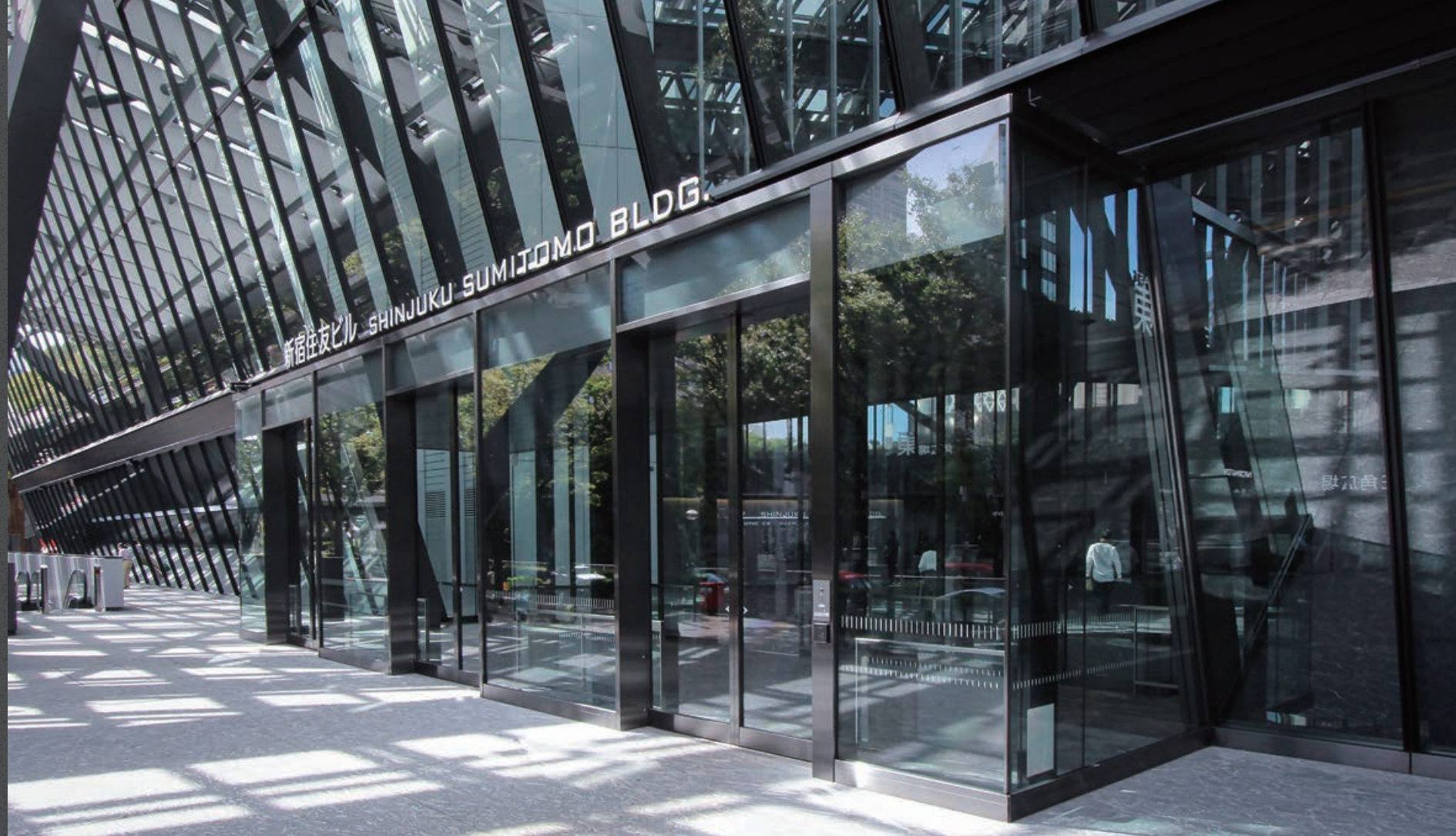
▲ 新宿住友ビルRE-INNOVATION PROJECT [東京都新宿区・2020] メインエントランス 風除室 | カラーステンレス（ブラック）ヘアライン仕上げ
