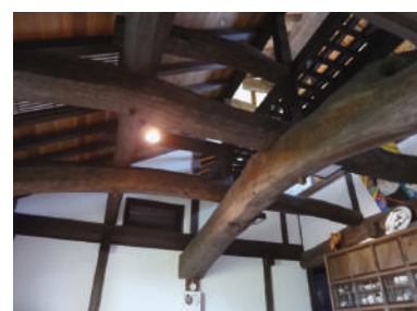
新築工事 内観写真
