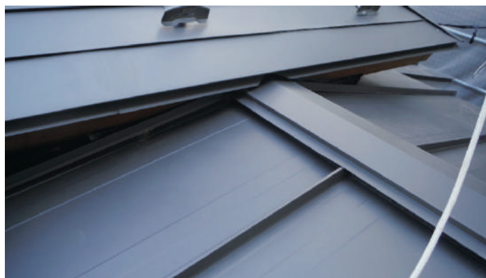
導入した折曲機で加工した屋根材
