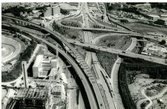
中国自動車道 吹田ジャンクション工事
