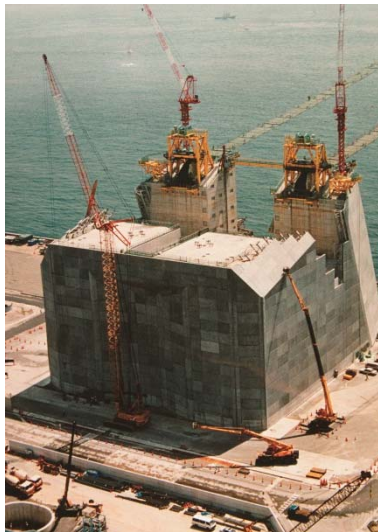
明石海峡大橋 1A 下部工工事・明石海峡大橋 1A 躯体工工事
