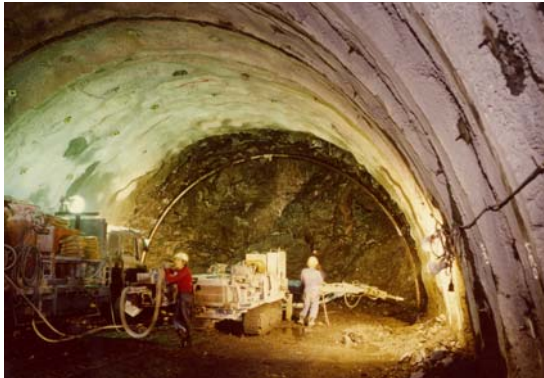
黒谷トンネル工事
