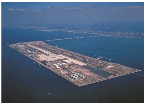
エブロン舗装工事
