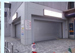
▲ 地下構内への浸水対策 (大鳥居駅西口)
