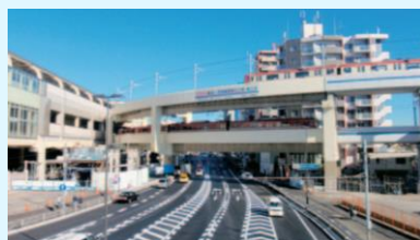
▲ 京急蒲田駅付近全線高架化
