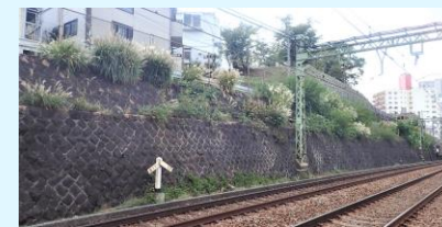
▲ 神奈川駅付近石積擁壁耐震補強
