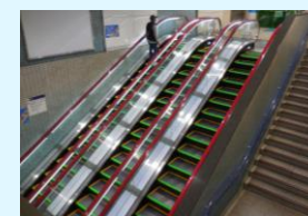
▲ エスカレーター・エレベーター更新
