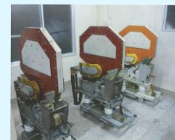
▲ 変電設備の更新
