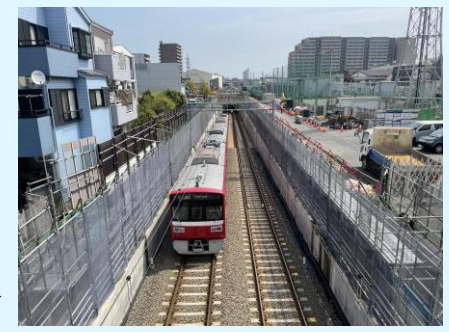
東門前～小島新田駅付近地下化工事 ▶
