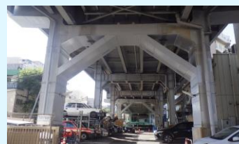
▲ 新馬場駅構内高架橋耐震補強
