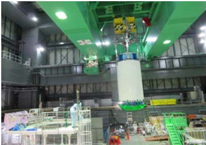
構内用輸送容器の吊り上げ (1)
