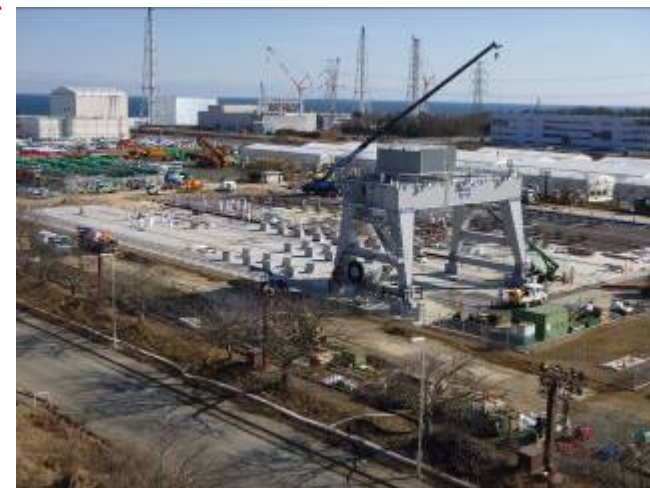
②工事の状況 (2013/1/31)
