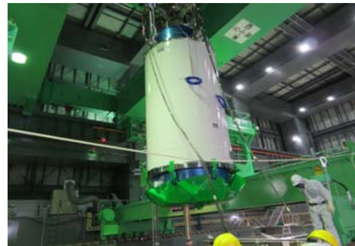
構内用輸送容器の吊り上げ (2)
