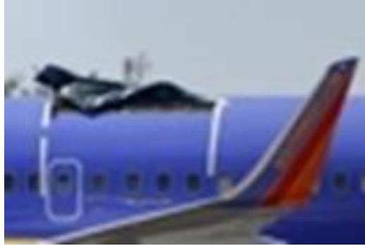
図 4.4 (5) - 1 B737-300 客室上部外板の破損 < Daily Beast 2012/7/16 > < USA Today 2011/4/4 >
