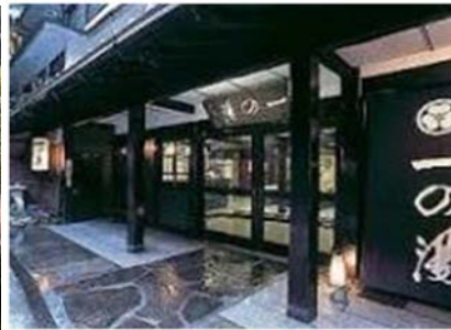
国道 1 号線に面した玄関口
