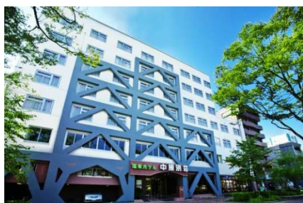
耐震改修のフレームをデザイン化したホテル正面
