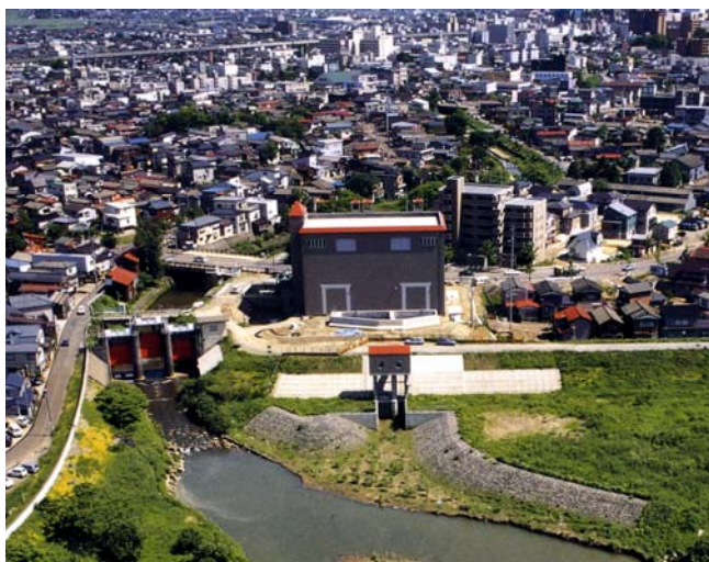
柿川排水機場
