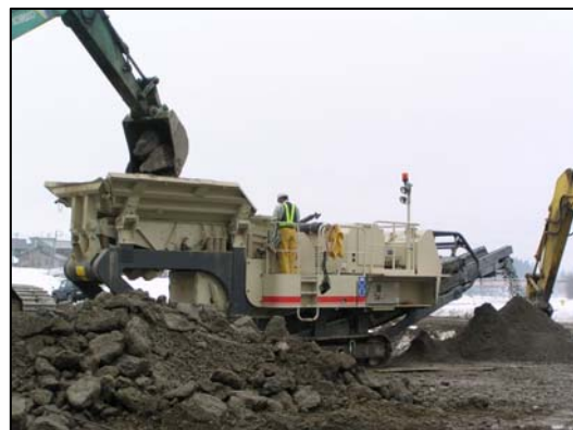
現場で廃材を加工
