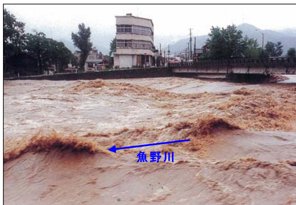
小出地区柳生橋の状況
