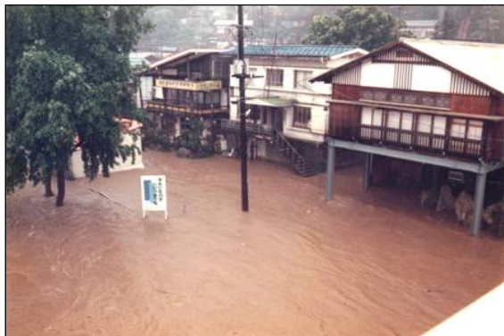
小出橋下流右岸の浸水状況
