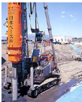
鋼管矢板工法（従来工法）
