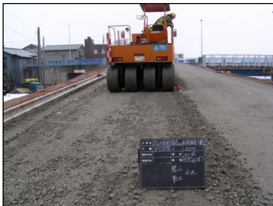
堤防天端の路盤に再利用
