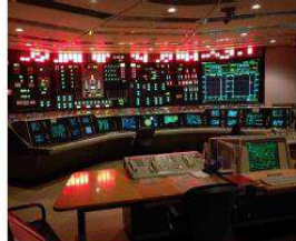
(直流非常灯照明点灯状態)
