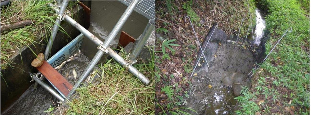
図 5. 外来魚の流出防止対策. 左:コンクリート水路の排水をカゴで受ける. 右:土水路の排水をトリカルネットで受ける.
